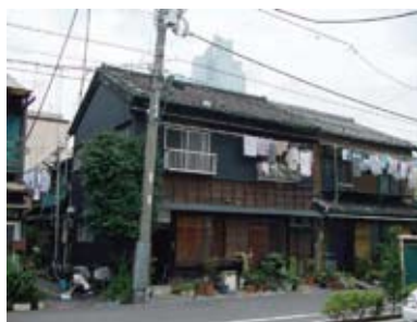
二軒長屋。玄関が両側にある。間取りだけではなく、ファサードも左右対称になっている
